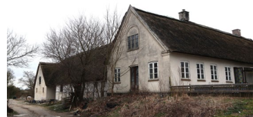
Gavl på det eksisterende stuehus
